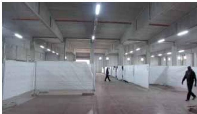
Centro di accoglienza di Palazzo San Gervasio. La "zona notte" allestita in una vasta porzione dell'ex tabacchificio (Medu/settembre 2014)
